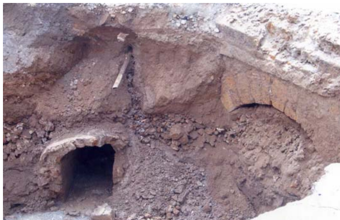
I resti del ponte medievale (a destra) e di un condotto fognario (a sinistra)
