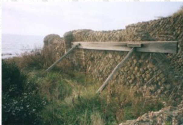
Villa delle Grottaacce a S. Marinella. Rinforzo a un muro sul lato Est della villa. (Archivio GATC)
