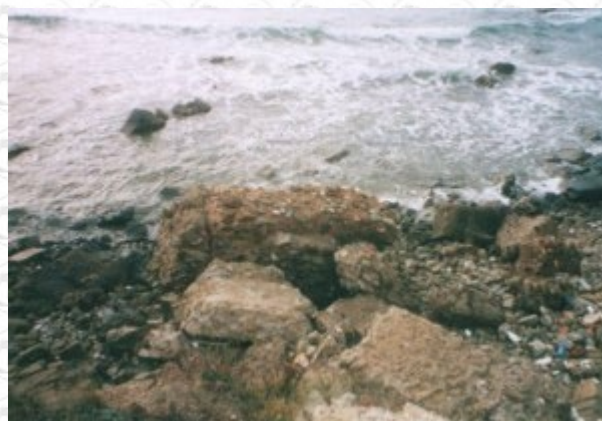
Villa delle Grottaacce a S. Marinella. Crollo. Affiorano dall'acqua le strutture della peschiera. (Archivio GATC)
