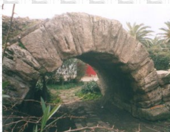
Ponti romani a S. Marinella. Ponte di Largo Impero, al km 60,400, realizzato ad arco con quindici conci radiali di pietra calcarea, congiunti con grappe di metallo. (Archivio GATC)
