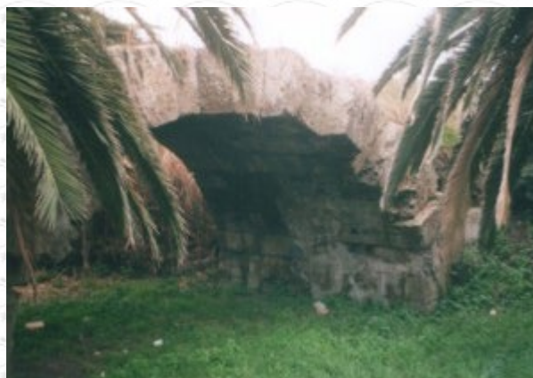
Ponti romani a S. Marinella. Ponte di via Roma, al km 60,700 dell'Aurelia, con arco a sesto ribassato realizzato con diciannove conci radiali in calcare. (Archivio GATC)
