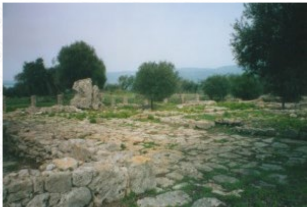
Cosa. L'area del foro. Sullo sfondo il crollo dell'arco a tre fornici. (Foto G. Marcello)
